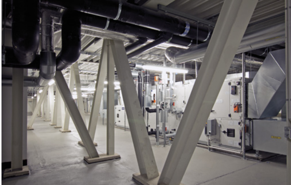
Das anspruchsvolle Tragwerk des :envihab wurde mit dem Preis des Deutschen Stahlbaues ausgezeichnet.
