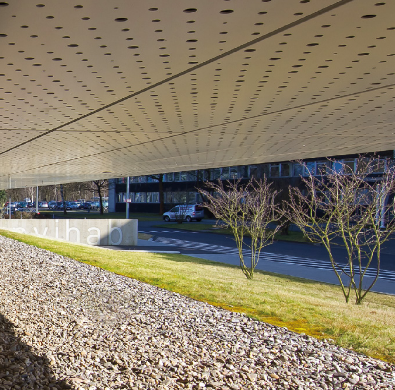
Das Dach scheint über dem leicht erhöhten Gelände zu schweben. Über die gläserne Lichtfuge kragt es noch hinaus.
