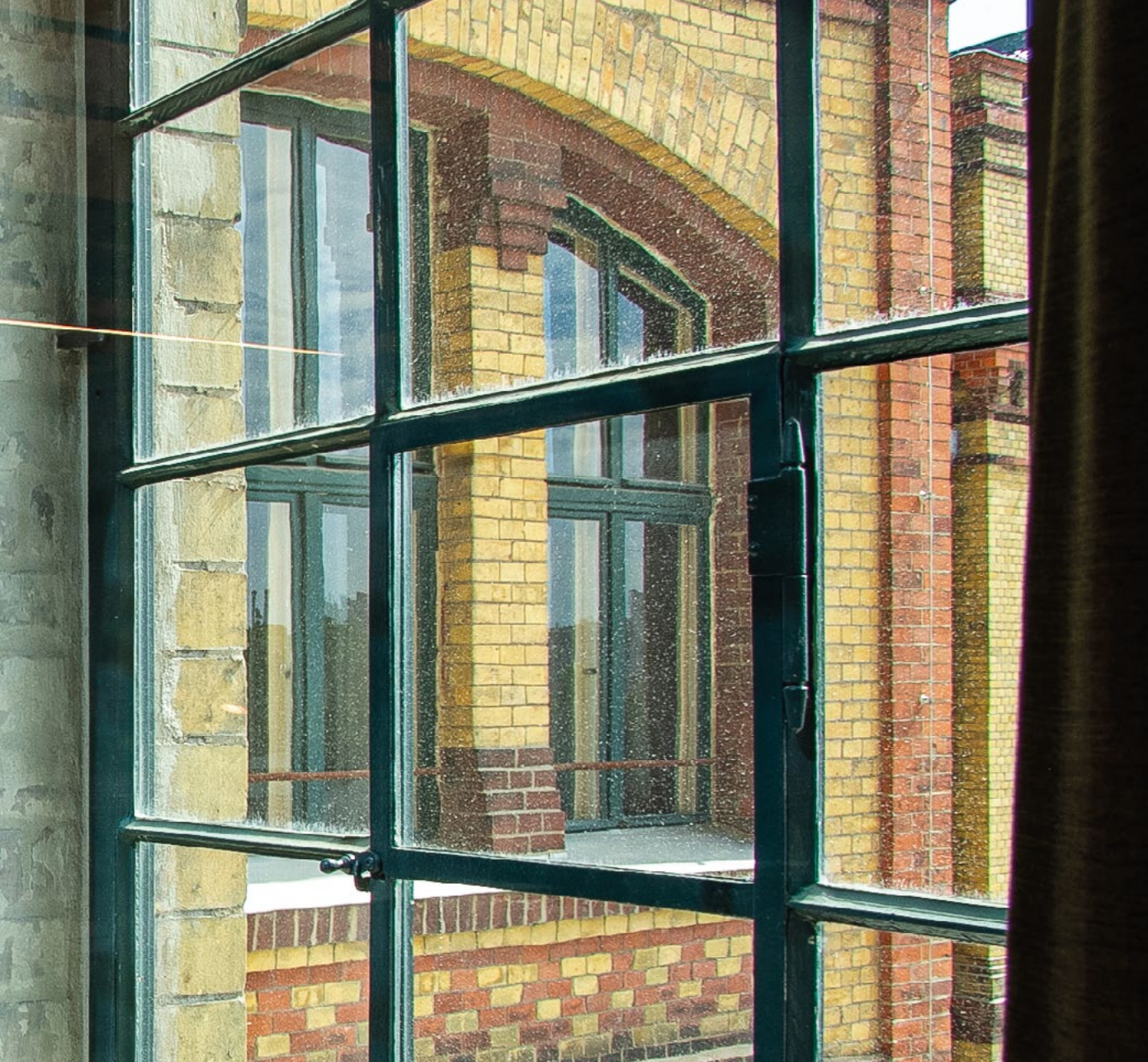
Die historischen Fenster konnten durch ein zusätzliches raumseitiges Fenster wärmeschutztechnisch ertüchtigt werden.
