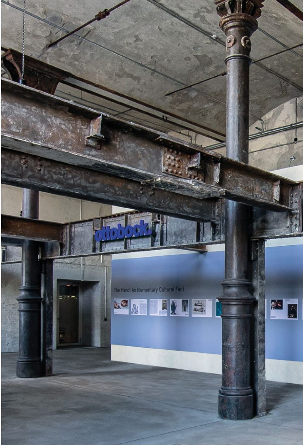
Das neue Foyer mit bauzeitlichen Säulen und einer nachträglich eingebauten Tragkonstruktion aus DDR-Zeit.
