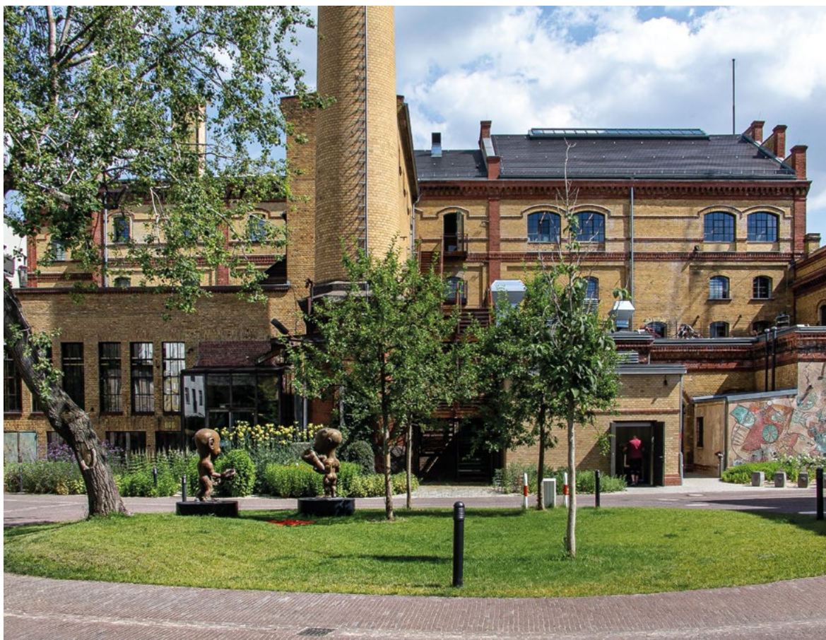
Hintere Ansicht des Hauses 2 mit Kesselhaus und hohem Schornstein.
