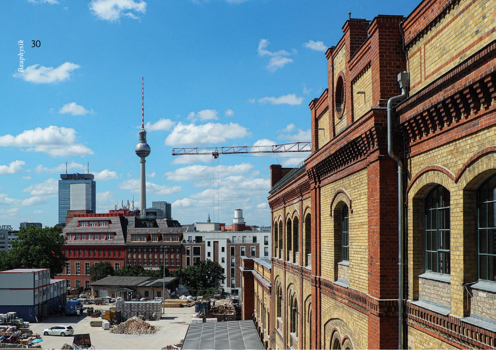
Viele Fenster waren einfachverglaste Stahlkonstruktionen – Blick vom Haus 1 Richtung Berliner Zentrum.
