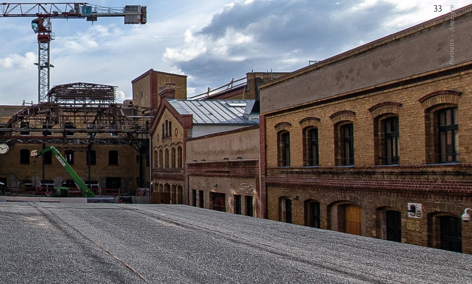
Blick von der Rückseite des Hauses 2 – im Hintergrund die laufenden Bauarbeiten an den weiteren Gebäuden.
