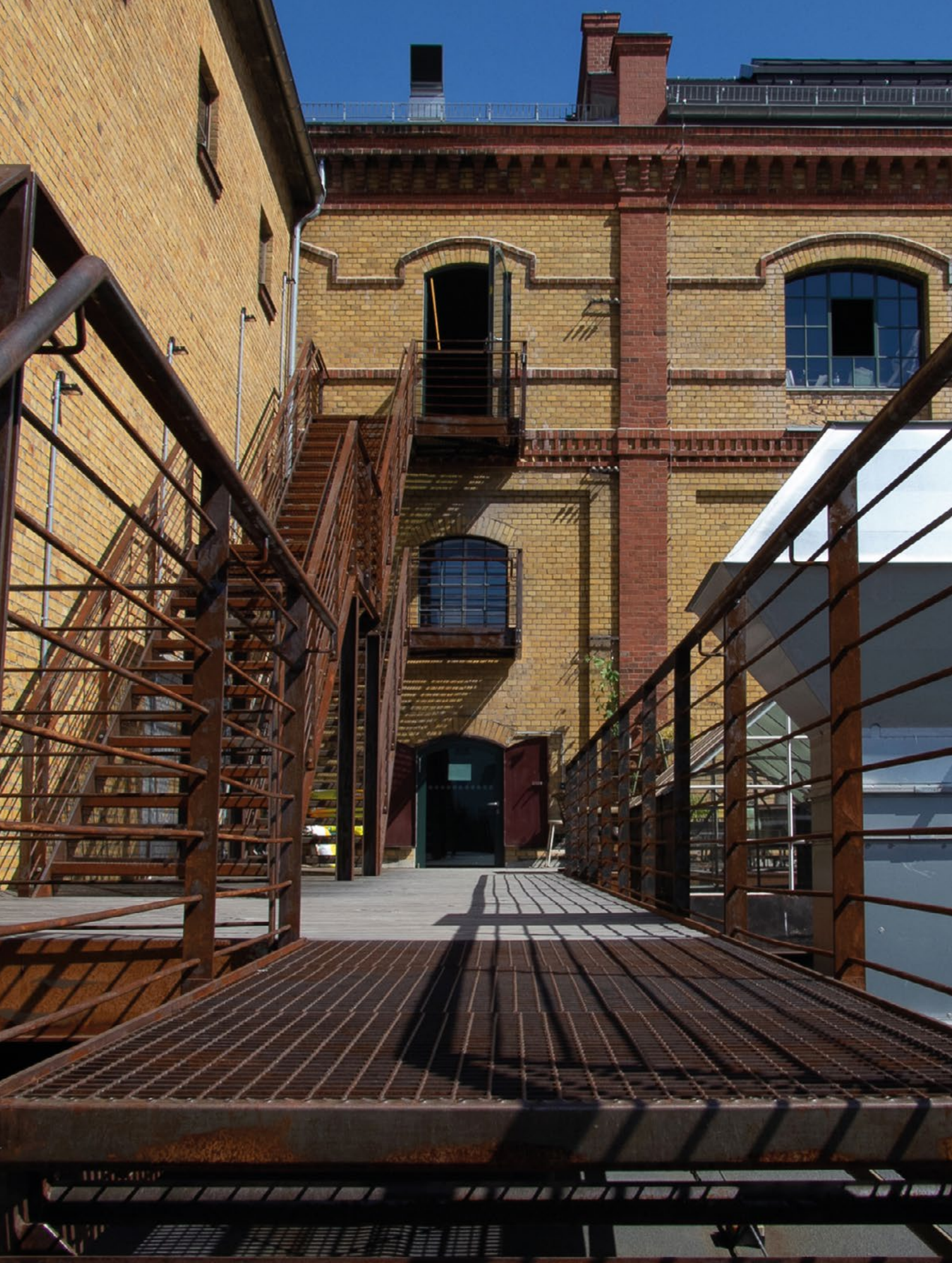
Die neue Eisentreppe über der großen Terrasse von Haus 2 verbindet die oberen Etagen mit der Terrasse und dem Patientengarten.
