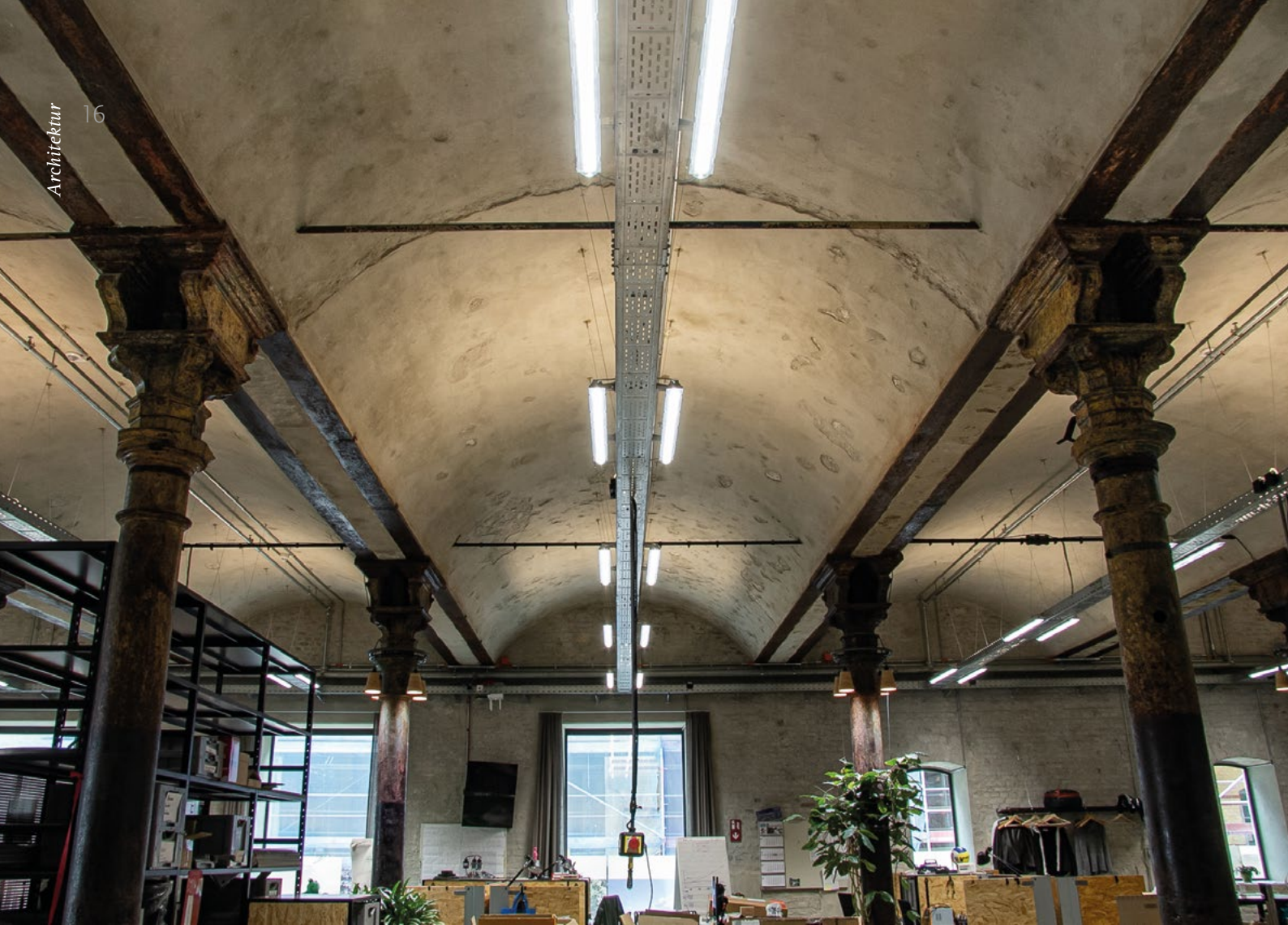
Bauzeitliche preußische Kappendecken mit gusseisernen Stützen in Haus 3.
